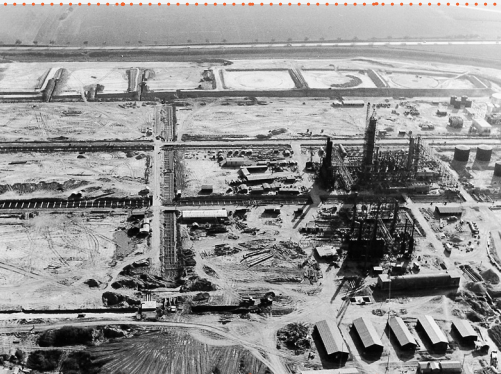
Baubeginn der Raffinerie Schwechat, 1958
