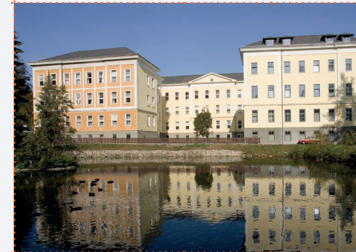
Areal des IST Austria in Maria Gugging, 2019
