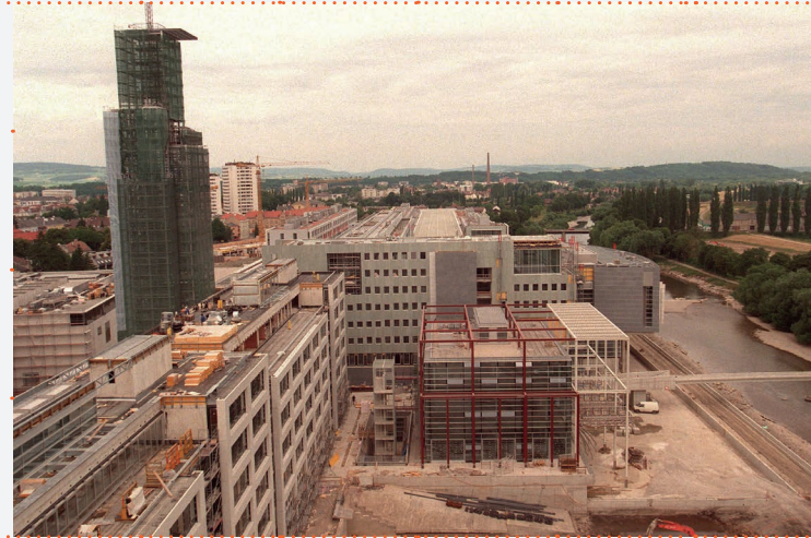
Bau des Landhausviertels in St. Pölten, 1996
